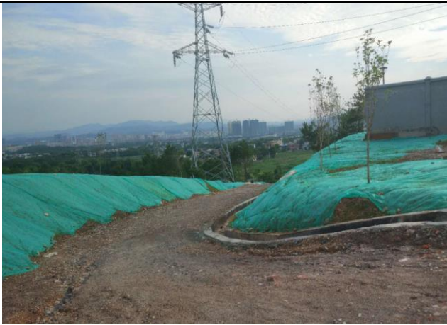
升压站进站道路
