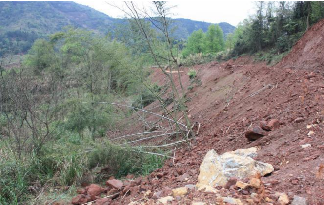
进场道路下边坡
