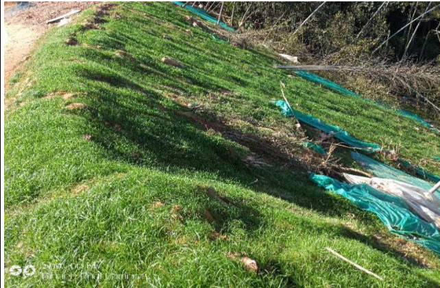
进场道路下边坡
