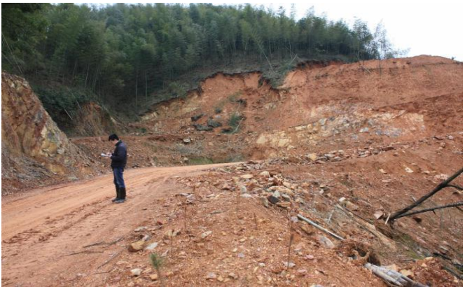
进场道路上边坡
