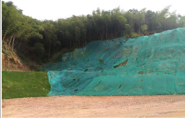
进场道路上边坡
