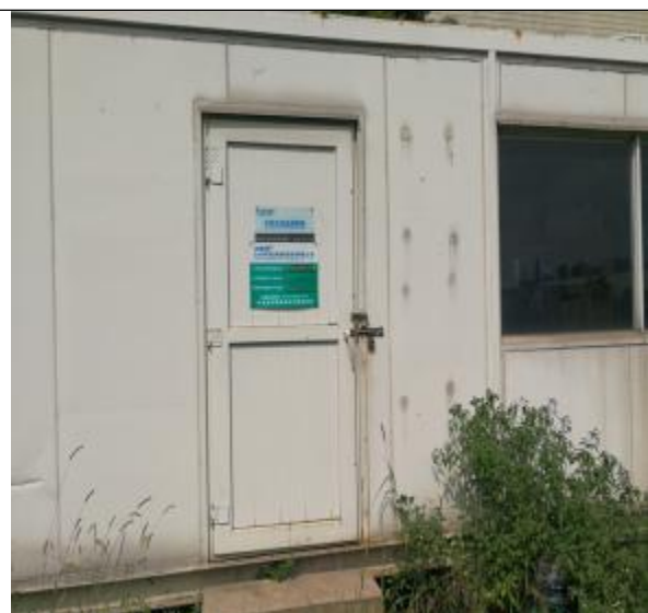
在线监控机房
