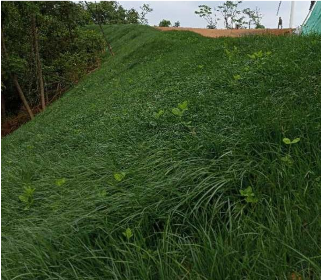
场内道路下边坡
