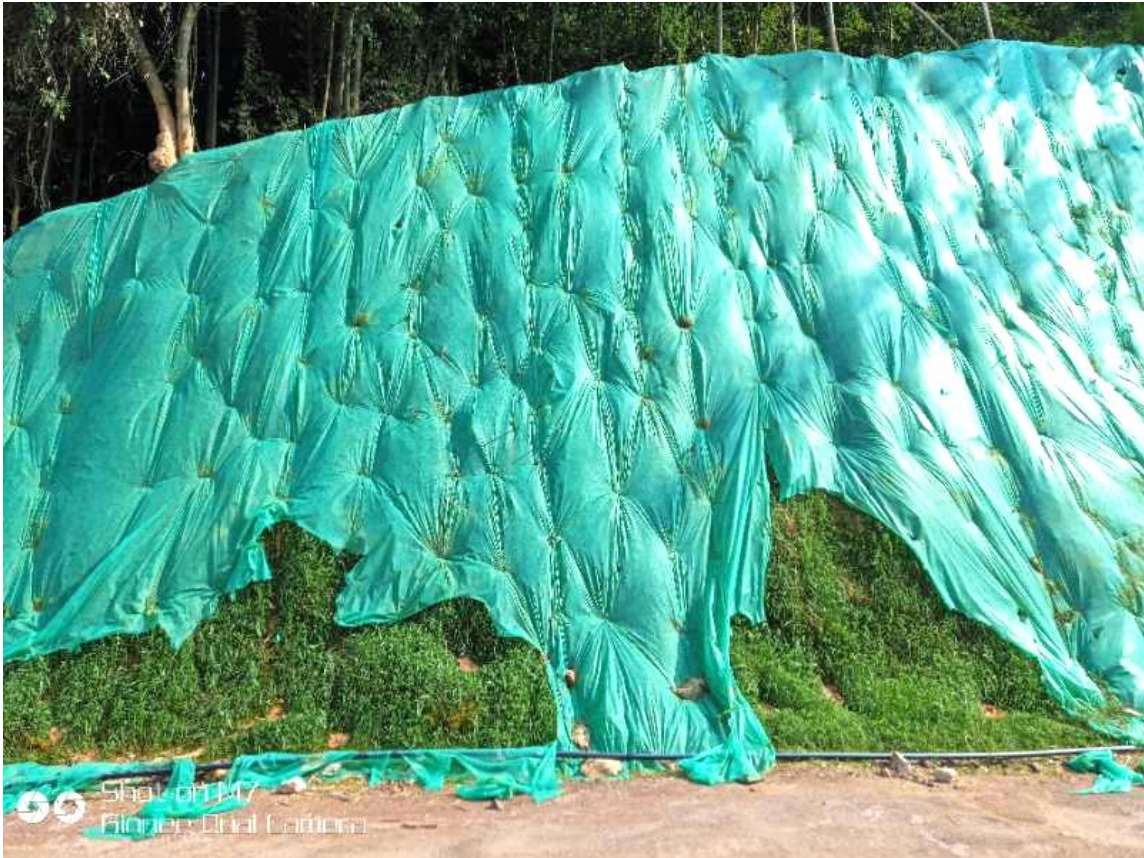
进场道路上边坡
