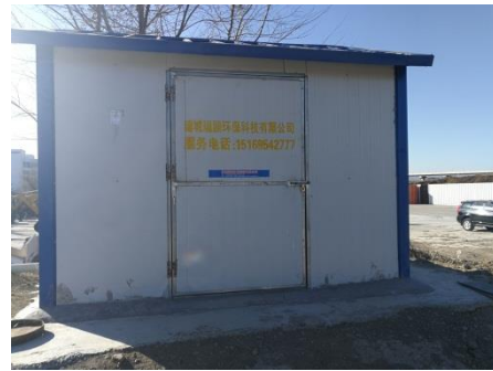
2、污水处理站设备间
